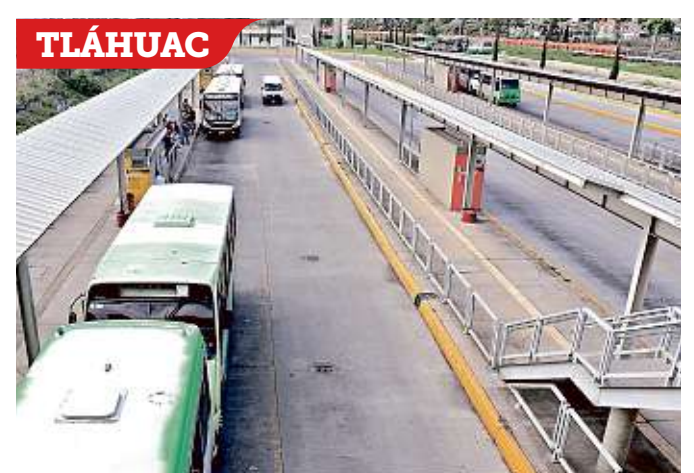
■ El Centro de Transferencia Modal tiene capacidad para mil 800 unidades en bahías que suman 20 mil metros cuadrados.
